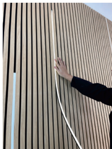
7. Setzen Sie das Produkt in die Nut der Platte ein.
