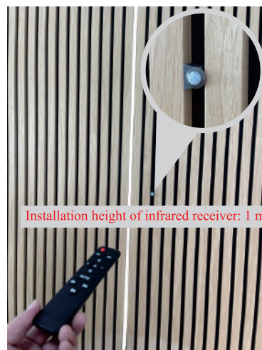
8. Montieren Sie den Empfänger der Fernbedienung in einer Höhe von 100 cm über dem Boden.
